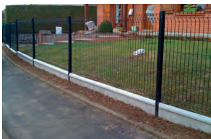
Avec une plaque béton 1/2 chaperon
