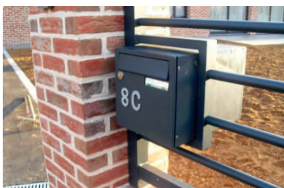
Intégrée à la clôture sur muret.
