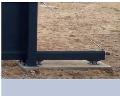
Le massif en béton armé
