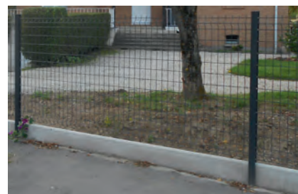
Avec une plaque béton lisse
